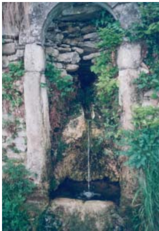
Fig. 8 – Travertino di sorgente (valle del ponte romano)
