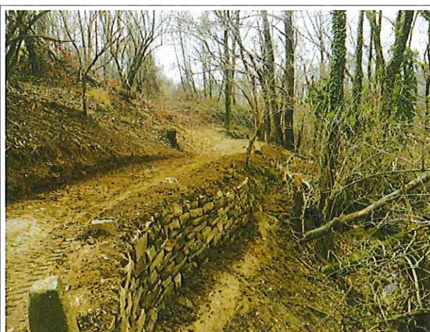
Rifacimento muratura sottostrada - Dopo
