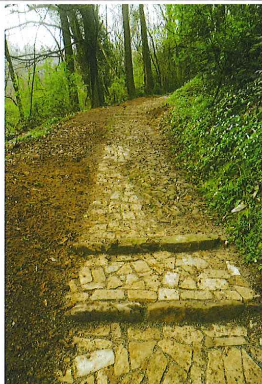
Esempio di rattoppo del sedime originale
